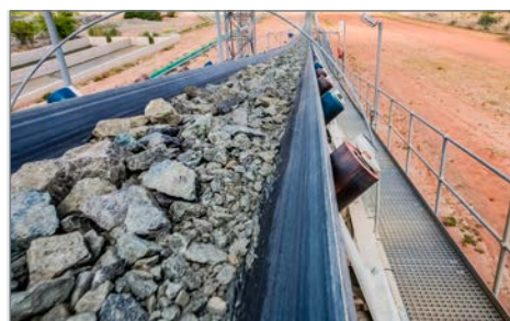
Surveillance des bandes transporteuses - utilisation d'un Xi 80 comme instrument efficace pour la protection contre l'incendie.
