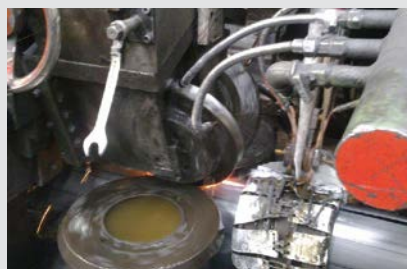
Surveillance de la température des rebords de conduits peu avant le soudage
